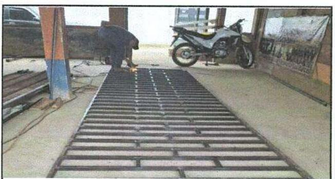
Foto 6: Sustitucion de balcones de metal.
